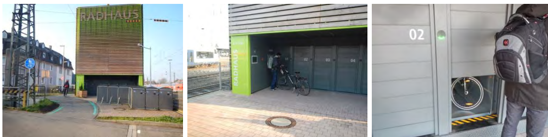
Figure 171 : Parc automatique à la station d'Offenburg („Radhaus“)
