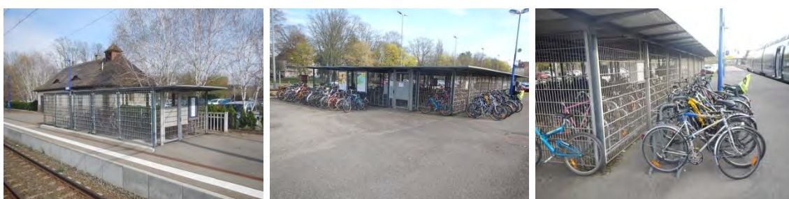
Figure 155 : Station de Haguenau: emplacements à vélos (abri pour plusieurs vélos, arceaux)
