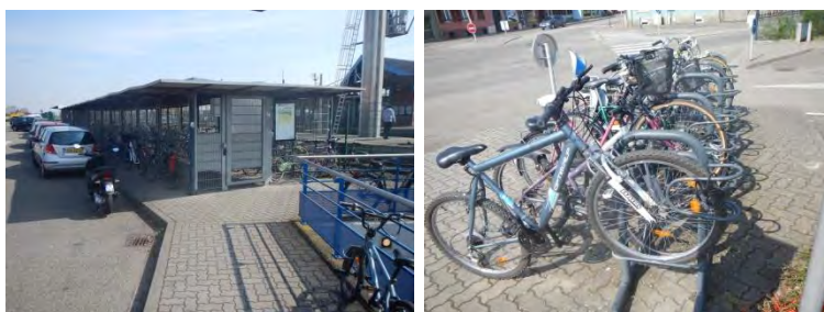
Figure 164 : Face sud: abri pour plusieurs vélos, arceaux
