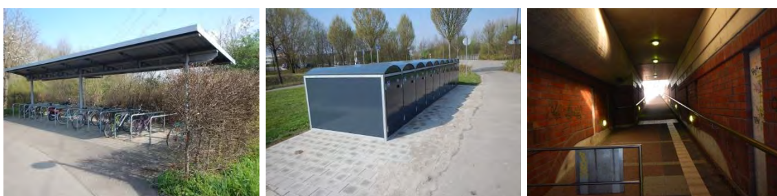
Figure 145 : Station Appenweier: emplacements à vélos à quai ouest (arceaux et boxes pour un vélo) et viabilité
