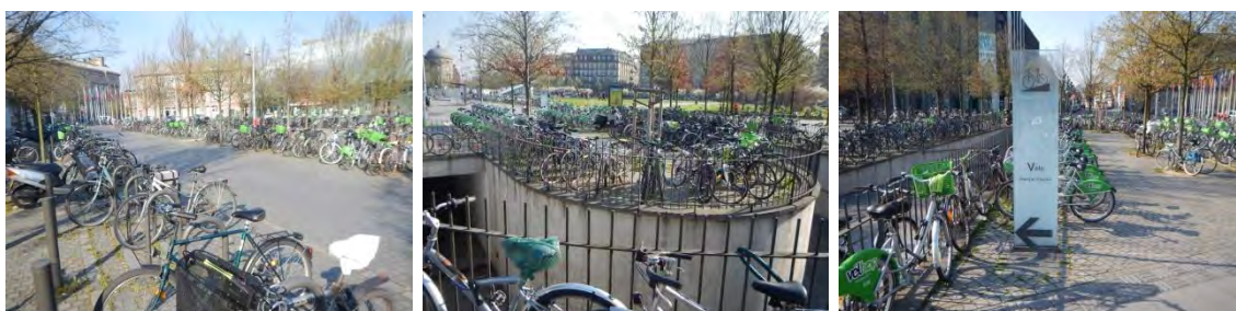
Figure 173 : Station de Strasbourg: Emplacements à vélos (arceaux) et viabilité
