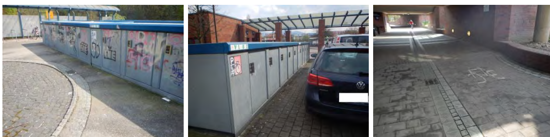
Figure 144 : Déficiets: graffitis (ouest), accessibilité limitée (est), illumination mauvaise
