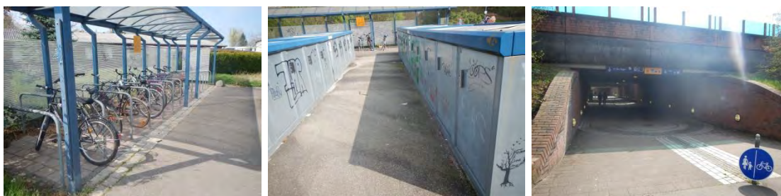
Figure 142 : Station d'Achern, Entrée ouest: parkings à vélos (arceaux couverts et boxes pour un vélo) et viabilité
