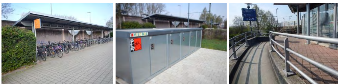
Bild 150 : Abstellanlagen bei östlichem Gleis (überdachte Rahmenhalter und Fahrradboxen) und Zuwegung zum Gleis
