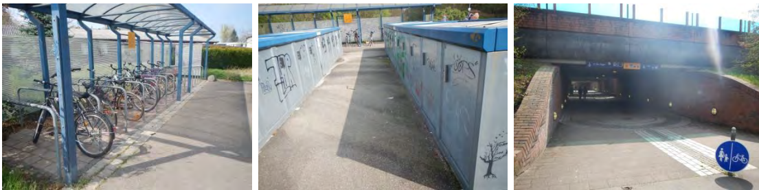
Bild 146 : Westseite: Abstellanlagen (überdachte Rahmenhalter und Fahrradboxen) und Zuwegung zum Bahnhof Achern
