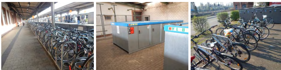
Bild 174 : Zugang Westseite: überdachte Rahmenhalter, Fahrradboxen, freie Abstellanlagen (tw. Vorderradklemmen)
