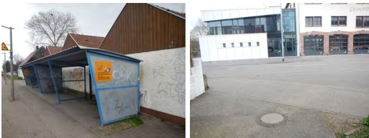
Bild 171 : Mängel Bike & Ride-Anlagen: alte Abstellanlage nicht entfernt, unzureichende Absenkung der Borde
