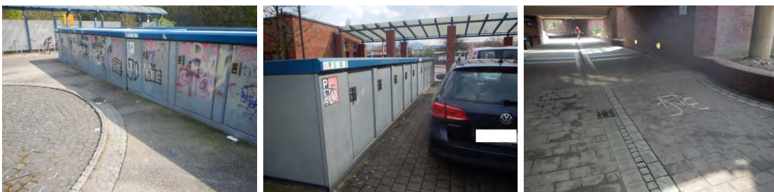
Bild 148 : Mängel Bike & Ride-Anlagen: Graffiti (Westseite), Erschließung zugeparkt (Ostseite), mangelhafte Beleuchtung
