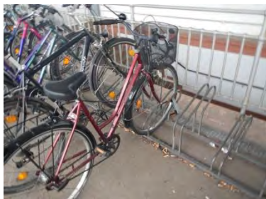
Bild 166 : Mängel: große Anzahl (tw. verbogene) Vorderradklemmen, schmale Rampe
