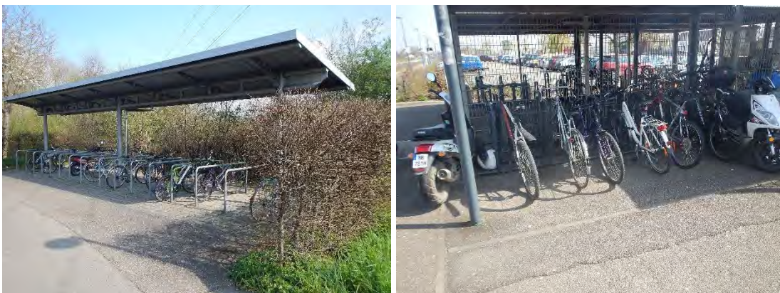
Bild 58 : Überdachte Rahmenhalter an den Bahnhöfen Appenweier und Molsheim
