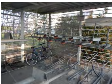
Bild 164 : Mängel: Veloparc (Anlage nicht genutzt, Parksysteme verbogen, Entfernung); Wildparker
